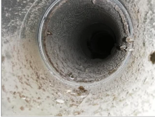
Ventilationskanal nr. 15E før
